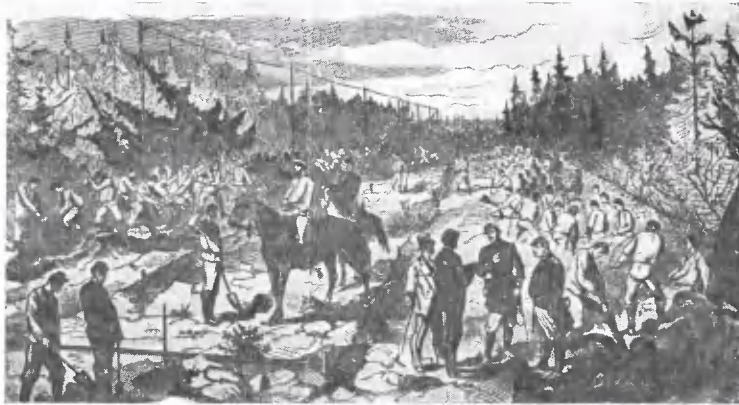
Прокладка железнодорожного пути в лесу
