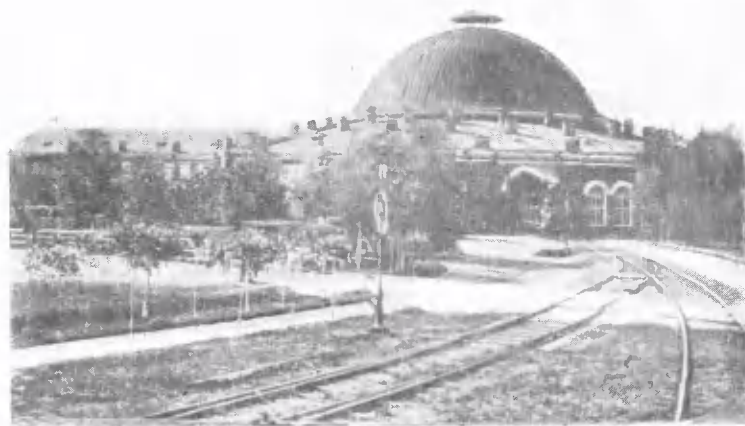
Локомотивное здание на станции первого класса
